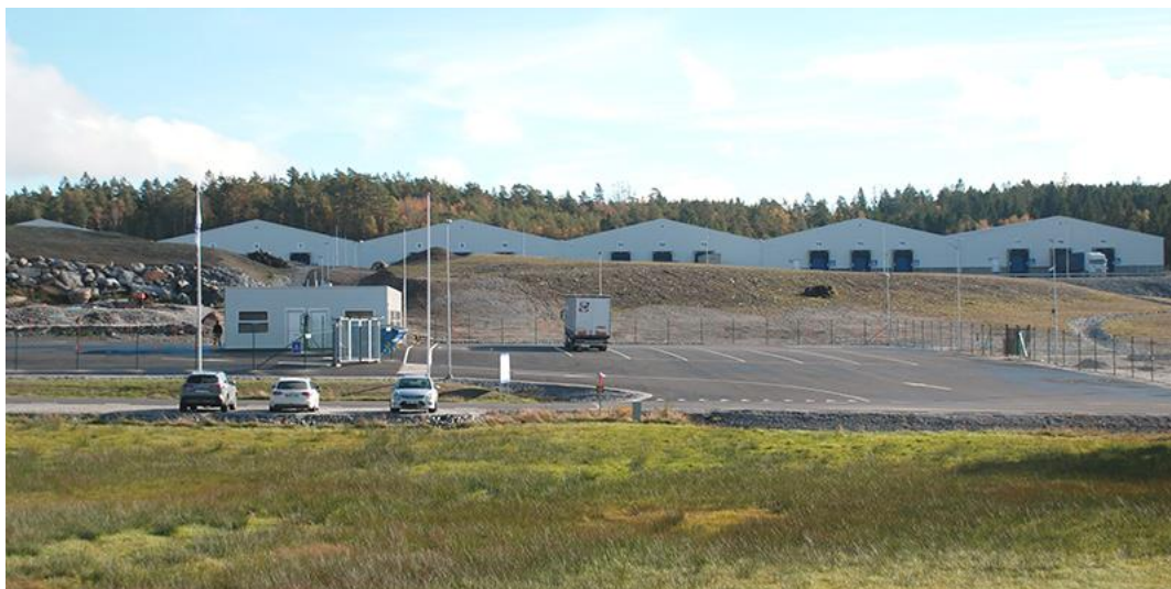
På bilden syns de nya lagerhallarna på Vedkullen vid Gategård som anslutits till vårt fjärrvärmenät under året.
